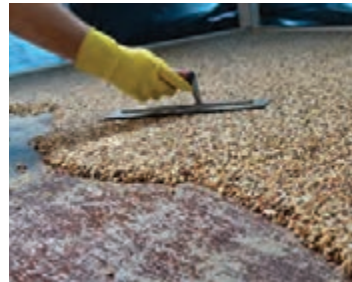
شکل ۳-۴۳- نمایش نحوه پخش و اجرای اپوکسی گرانیتی
