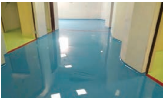
شکل ۴-۱۱- اپوکسی به عنوان لایه نهایی کفپوش
