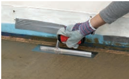
شکل ۴-۸- از قابلیت‌های دیگر فوم بتن محافظت از لوله‌های تأسیساتی است شکل ۴-۹- پرداخت سطح فوم بتن جهت اجرای پوشش نهایی
