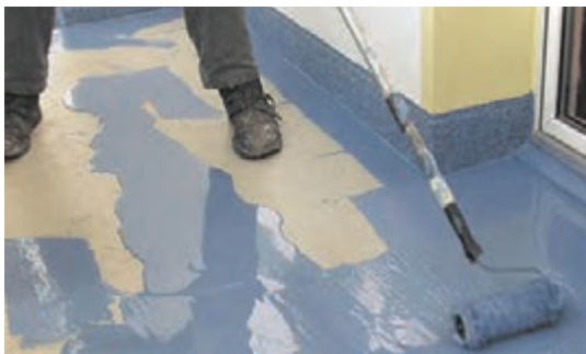
شکل ۴-۱۰- یکی از روش‌های اجرای اپوکسی
