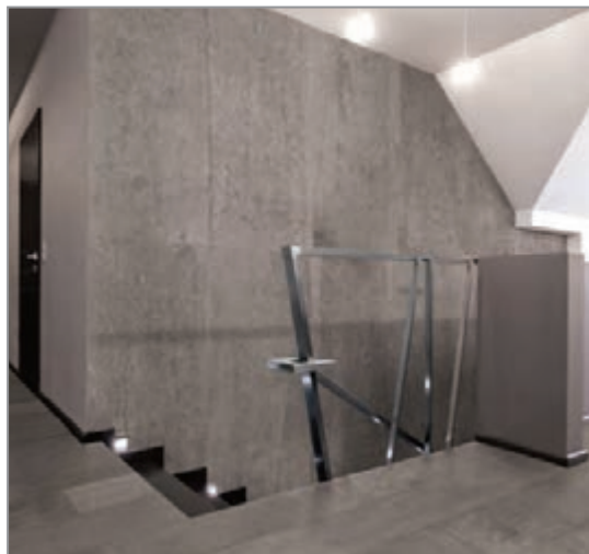
شکل ۴-۱۵ یک جداره داخلی از بتن نمایان قالبی
